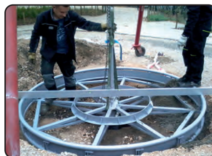
Installation of foundation part. Montage der unterirdischen Konstruktion.
