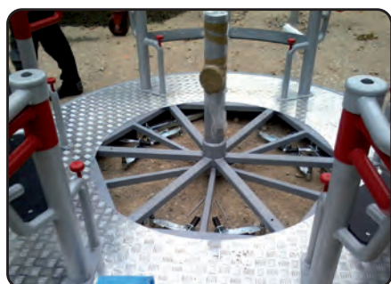
Installation of upper part. Einbau von beweglichen Elementen.
