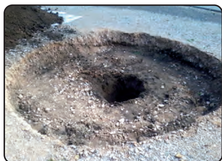
Ground works. Erdaushub Vorbereitung.
